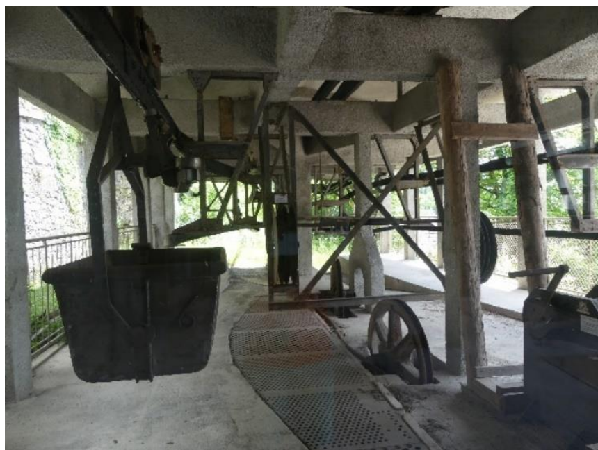
Installations de convoyage – Mine d'Ildrija
